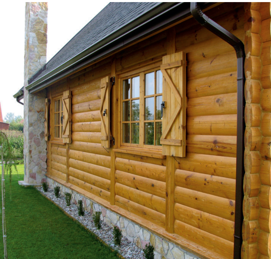
Przegroda zewnętrzna zbudowana jest z drewna o grubości 5 cm.
